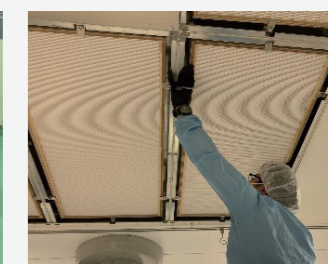
HEPAフィルター交換作業
