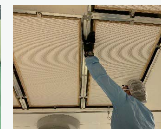
HEPAフィルター交換作業
